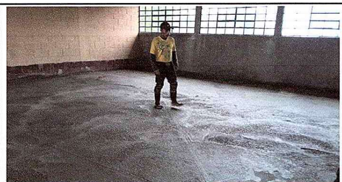
Foto 5: vista panoramica del corredor, reparacion de pisom y la instalacion de puertas del establecimiento.
