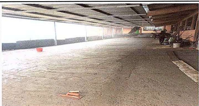
Foto 3: como se muestra en la fotografia despues de realizar los diferentes procesos de cambios del corredor del establecimiento.
