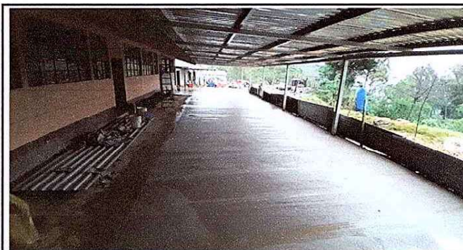
Foto 6: Observandose los diferentes procesos realizados en la cocina y la colocacion de canales y bajadas de asgua pluvial.
