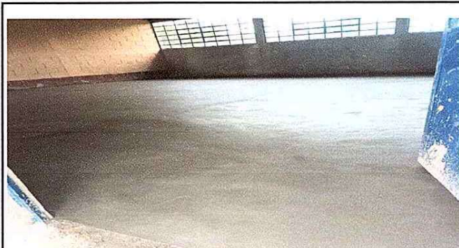
Foto 2: vista Frontal del establecimiento, cambios y fundicion entortado de piso de una alua.
